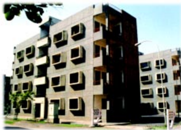
MIG flats at Narela
